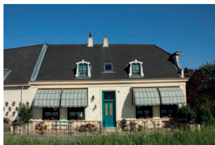
Het voormalige Post- en Veerhuis in Strijensas
