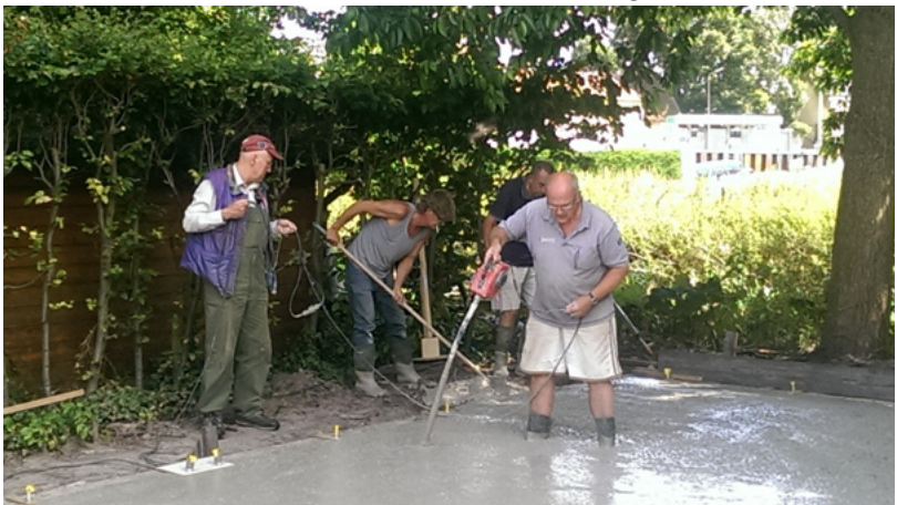
Voortgang werkplaats. V.l.n.r.: Jan Willem, Guus, Jacob en Jan zorgen dat zoveel mogelijk luchtbellen uit het vers gestorte beton ontsnappen. Foto: Belle van den Berg 11
