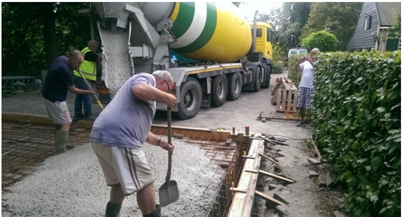
Het verdelen en uitsmeren van het gestorte beton. V.l.n.r.: Jacob, (betonleverancier), Jan en Cor. Foto: Belle van den Berg
