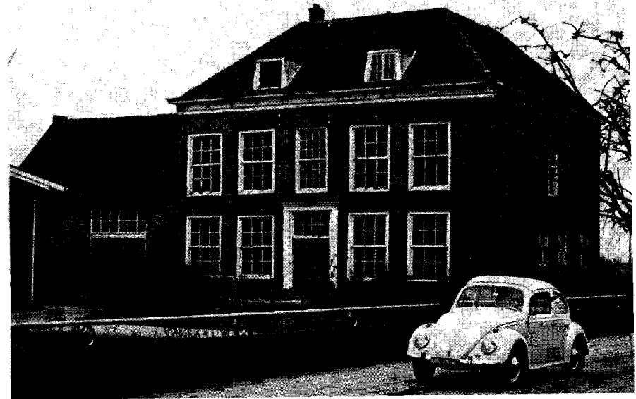
't Hof van Assendelft voor de restauratie van 1966 - 1968.
