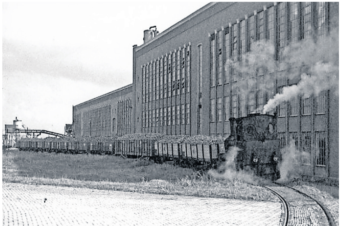
De 'bietentram' - Suikerfabriek Puttershoek (Collectie MHW)
